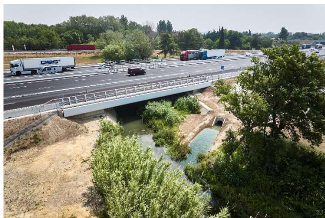
Le pont franchissant la Touloubre, élargi, ©J-P Moulet pour VINCI Autoroutes
