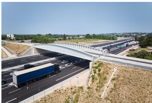
Le pont de la RD68 allongé et élargi accueille une voie modes doux ©J-P Moulet pour VINCI Autoroutes
