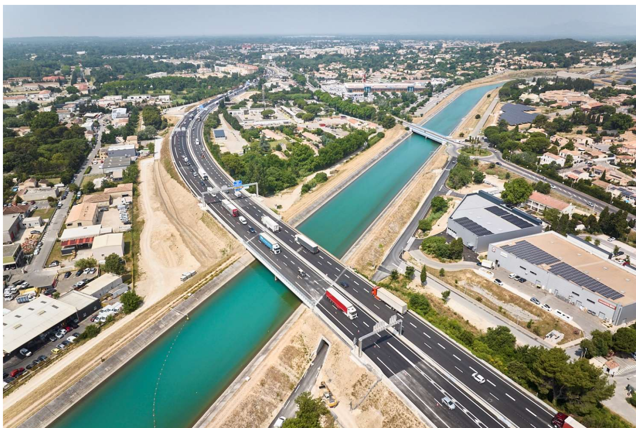
Le pont sur le canal EDF, dont le tablier sud a été remplacé et élargi - ©J-P Moulet pour VINCI Autoroutes
